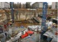
Zajrzyj na budowę 90-metrowego wieżowca w Warszawie [ZDJĘCIA CZYTELNIKA]
